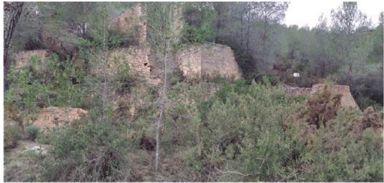
3. Conjunto de silos, arcos de medio punto y contención del terreno
